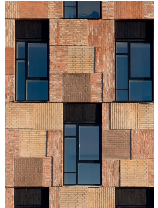
Avfallsmateriell har fått nytt liv i "The resource rows" av Lendager group . Foto: Danish design review.
