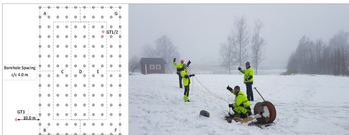
Figur 34 Sesongvarmelageret ved Xylem i Emmaboda i Sverige består av 140 borehull til 150 meters dybde og 4 meter mellom borehullene (boreplanen til venstre er hentet fra 37 ). Bildet til høyre er tatt i forbindelse med installasjon av fiberoptisk kabel i observasjonsborehullene (GT1/2 og GT3) for kontinuerlig måling av temperaturprofiler og som en del av forskningsprosjektet RockStore. Varmelageret er isolert med 40 cm skumglass. Ved monteringen av fiberkabelen i februar 2019 var temperaturen i grunnen 30-35 °C og området var dekket med snø.
