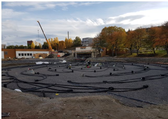
Figur 33 GeoTermos i Drammen. Bildet til venstre viser brønntopper og rørsystemet til brønnene, mens bildet til høyre 40 viser at det samme området nå er parkeringsplass.
