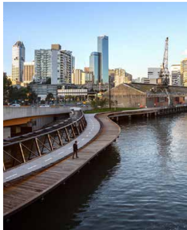
Skulpturell gang- og sykkelbro Jim Stynes Bridge, Melbourne. Foto: Cox Architecture
