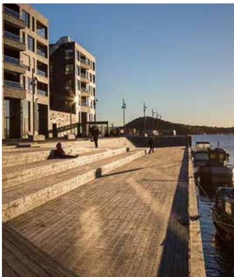
Offentlig sjøbad og kaikant i tre. Sjørenga Sjøbad. LPO. Foto: LPO
