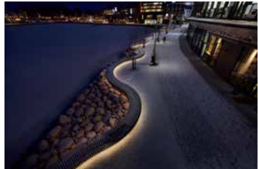
Langsgående kant, Helsingborg og Hornsberg strandpark
