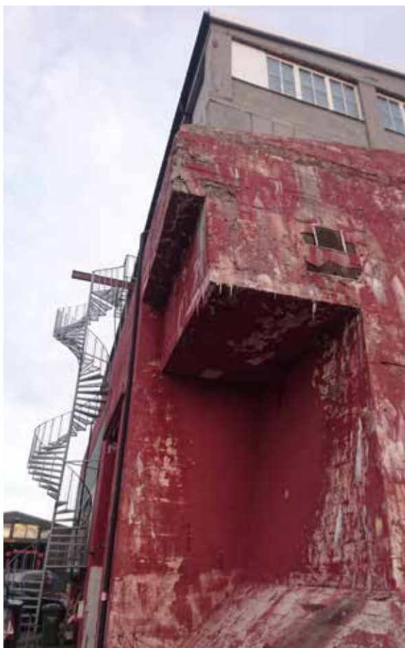
Fyringsbunkeren. Foto: Trondheim kommune
