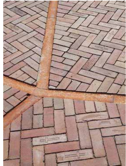
Gategulv som gir identitet til området, St. Plechelmuss square. Foto: Bureau BB
